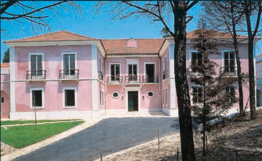
EDIFÍCIO ANIM – ARQUIVO NACIONAL DAS IMAGENS EM MOVIMENTO, BUCELAS | FOTO: LUÍS PAVÃO
